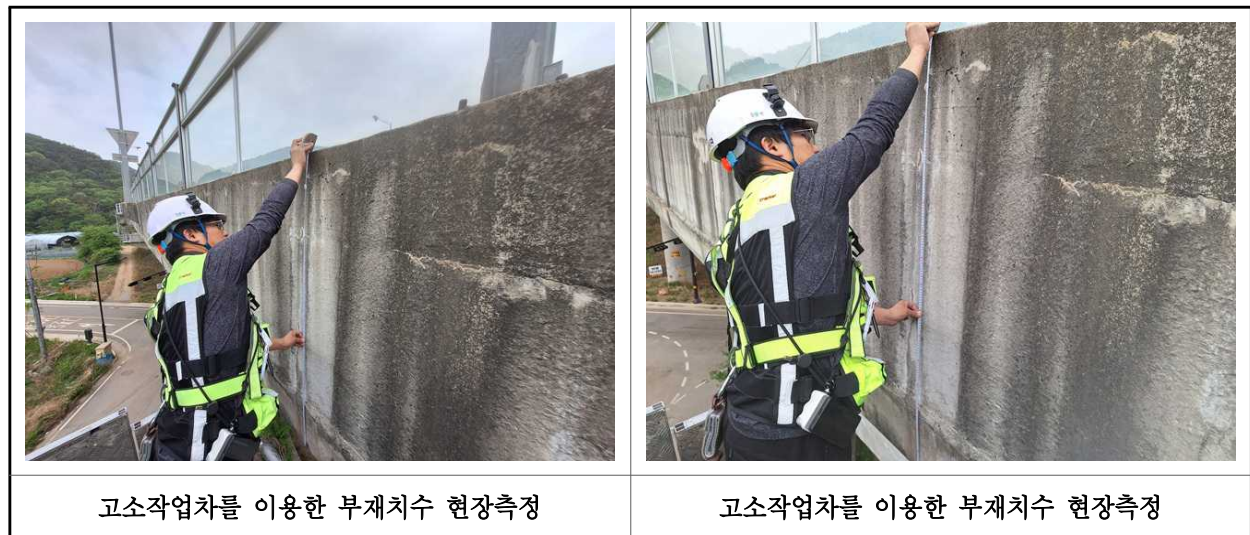
【사진 5.2.2】 부재 현장측정 전경
