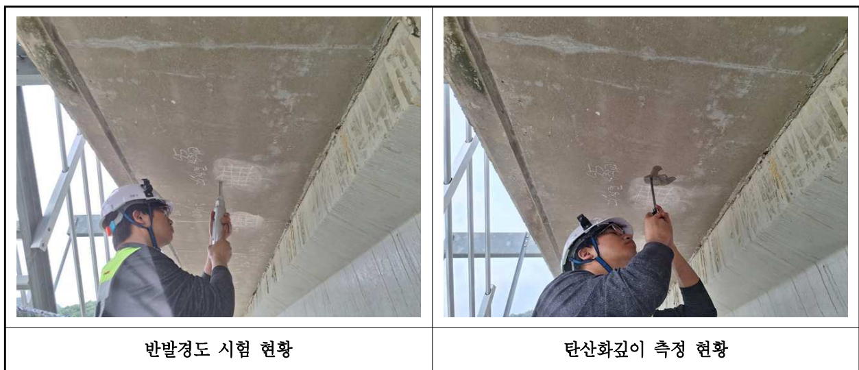
【사진 5.4.1】 콘크리트 내구성조사 현황
