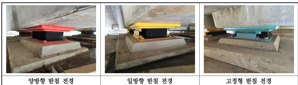
【사진 5.3.15】 교량받침 전경
