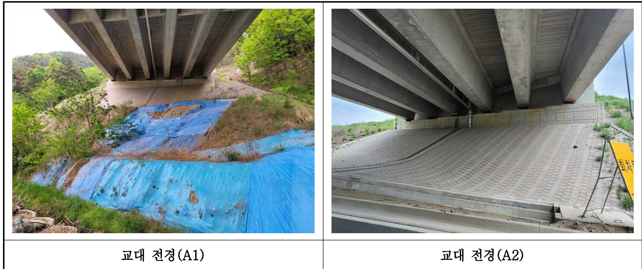
【사진 5.3.8】 교대 전경
