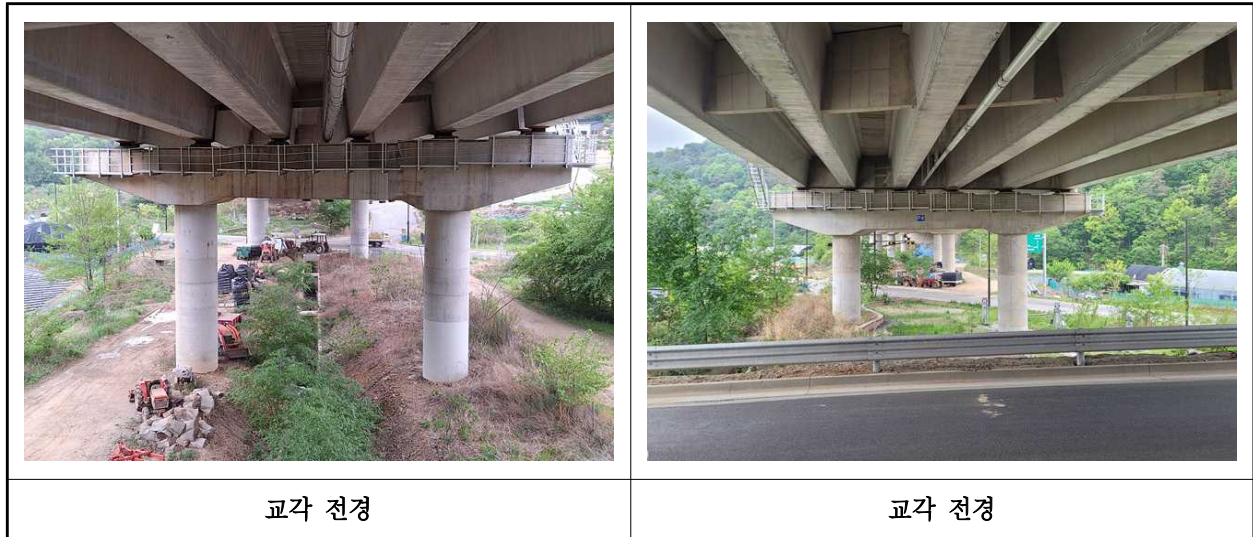
【사진 5.3.11】 교각 전경
