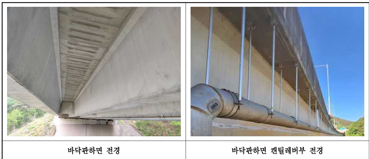
【사진 5.3.2】 바닥판하면 전경
