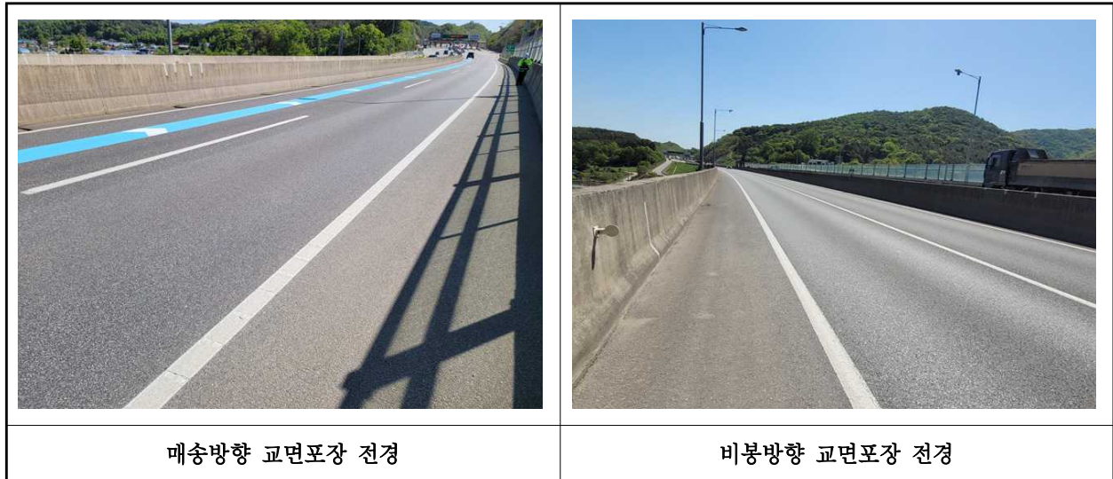
【사진 5.3.22】 교면포장 전경
