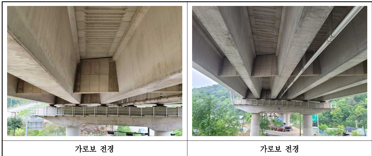
【사진 5.3.6】 가로보 전경
