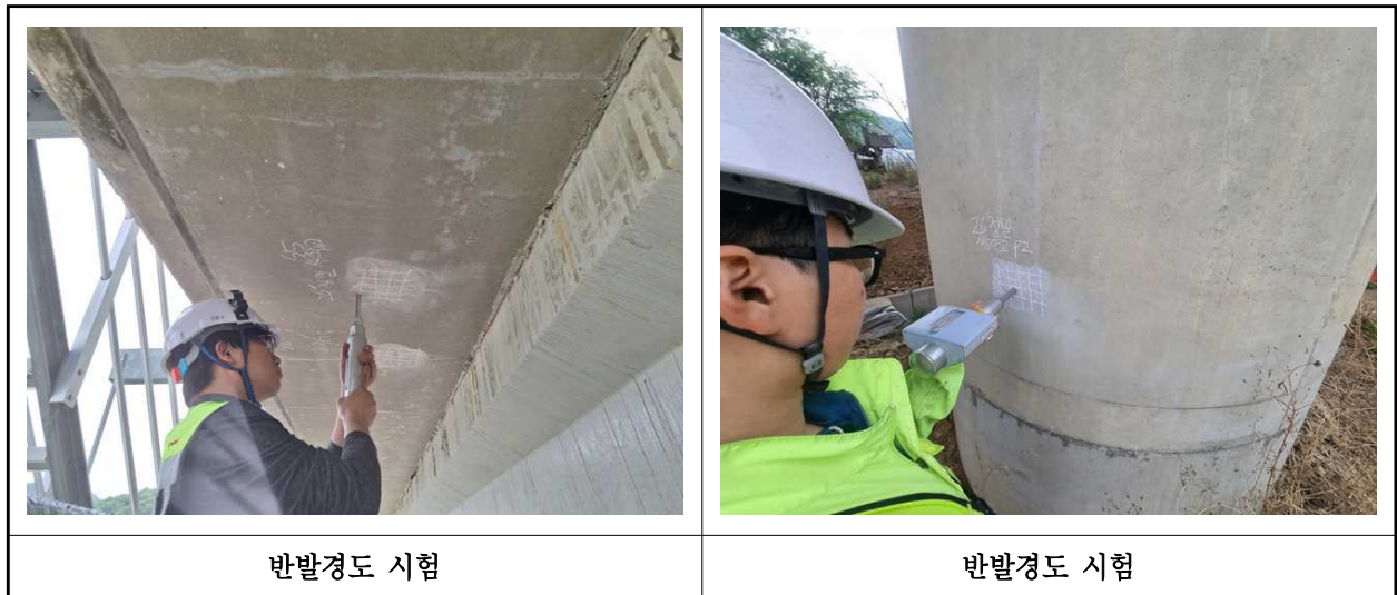
【사진 5.4.2】 반발경도시험 현장사진
