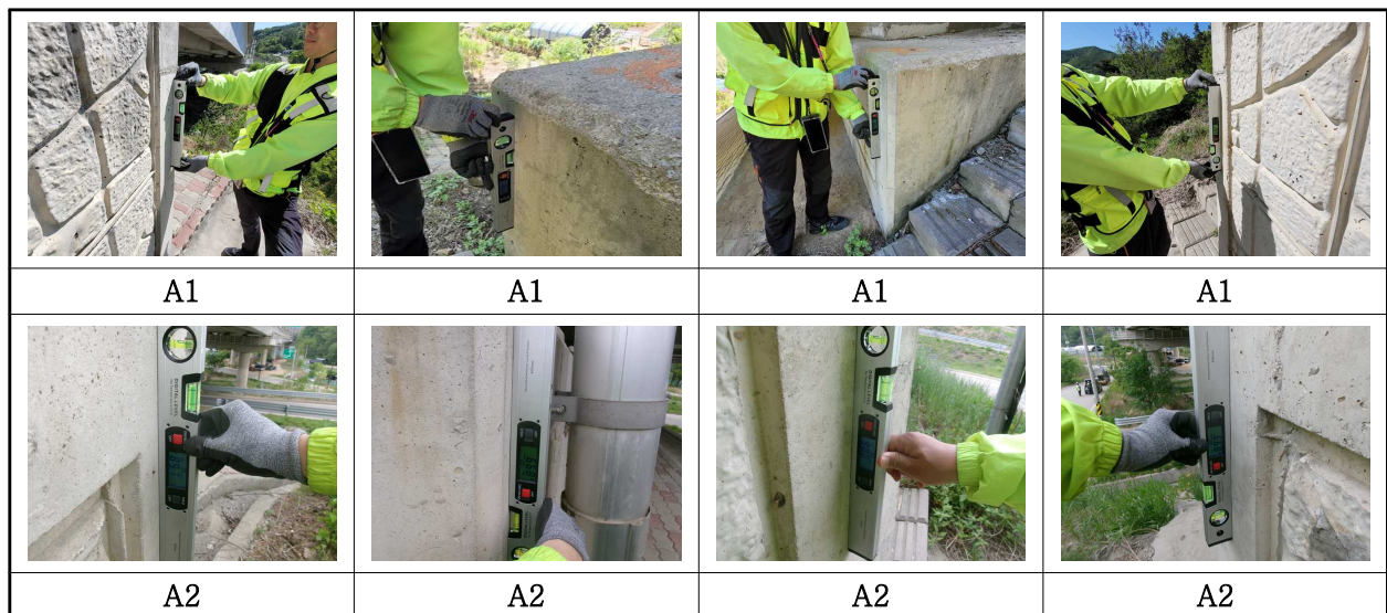
【사진 5.3.10】 교대 기울음 측정 현황
