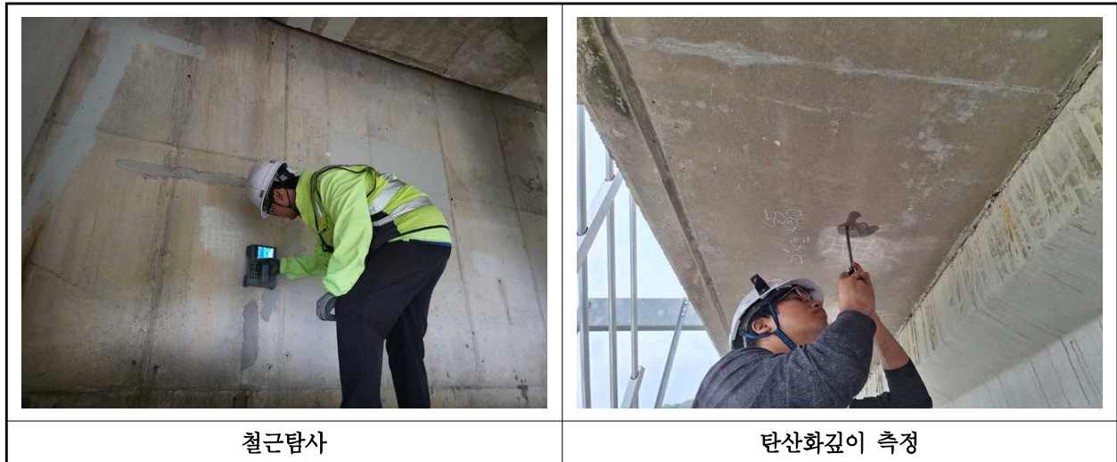
【사진 5.4.3】 탄산화 깊이 측정 현장사진
