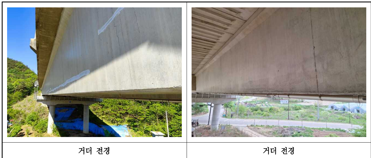
【사진 5.3.4】 거더 전경
