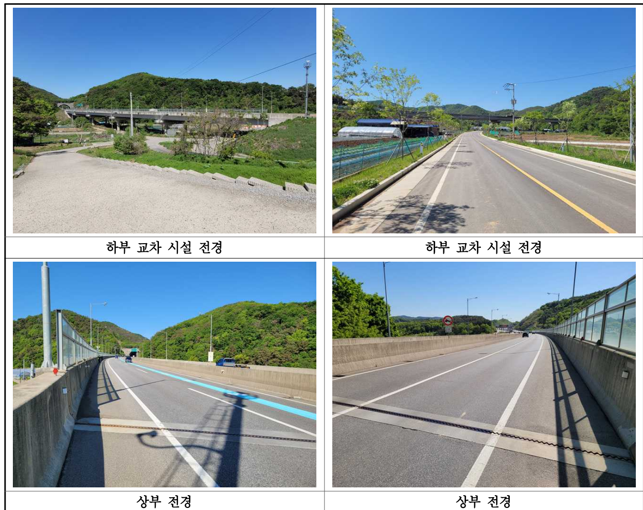
【사진 5.2.1】 주변환경 및 하중변화 전경
